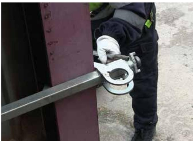
Se procederá al ajuste del sistema regulable, aplicando una fuerza máxima de hasta 50 Nxm.
