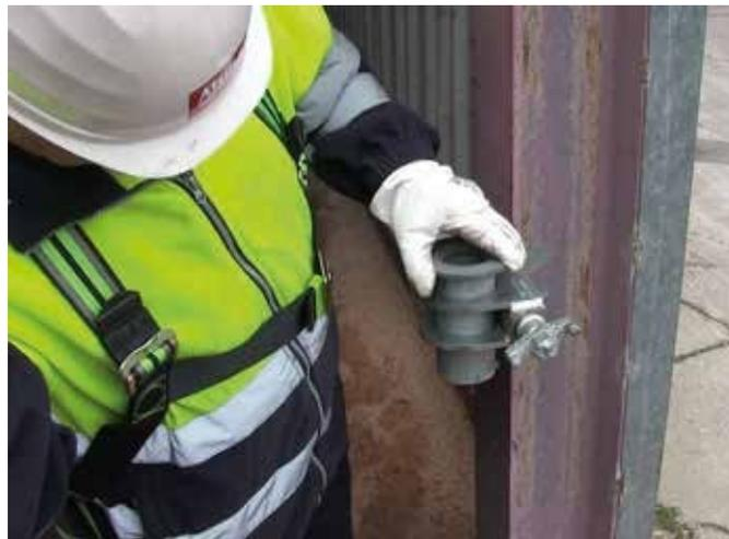
En la pinza que se ubica en posición inferior, se instalará el elemento VASO, cuyo diseño de doble perforación permite evitar una separación accidental.
