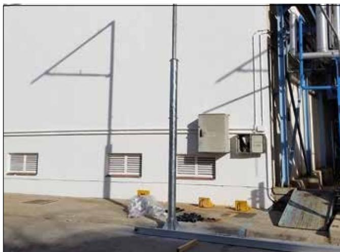
Mediante la utilización de equipos auxiliares, se incertará el Alsipercha por dentro del orificio central del POSTE, haciendo tope en la posición adecuada que garantice una adecuada nivelación del sistema.
