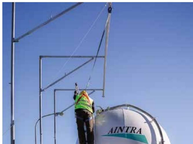
El usuario ya estará en disposición de conectarse al dispositivo retráctil conectado al Alsipercha, y comenzar a desempeñar sus labores con total protección.
