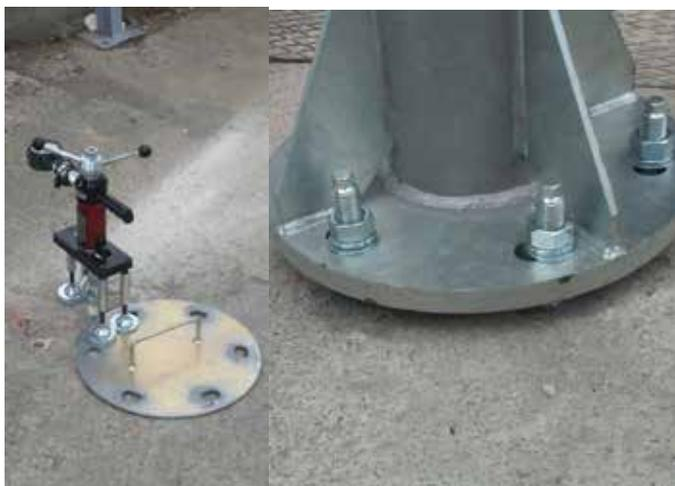
Mediante la utilización de una plantilla, se realizarán todos los agujeros que se utilizarán para el proceso de instalación de los anclajes que sujetarán el poste.
