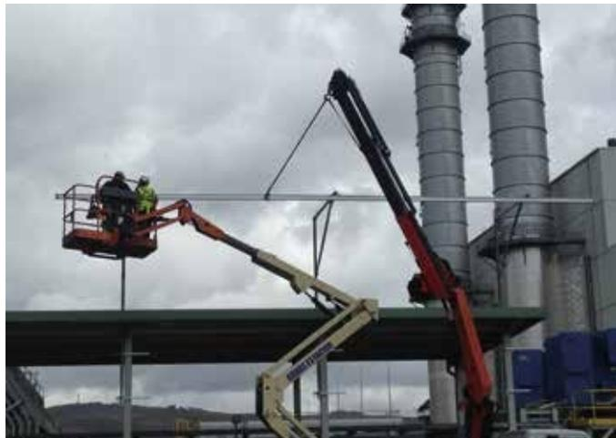
Alsipercha + Pinza para pilar metálico + Raíl
