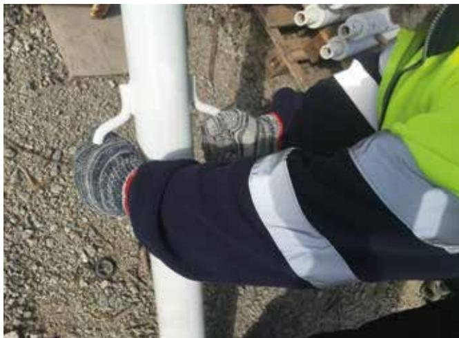
mediante el ajuste de los elementos regulables (tornapuntas), girando en sentido de cierre o apertura, hasta conseguir la posición óptima de utilización.
