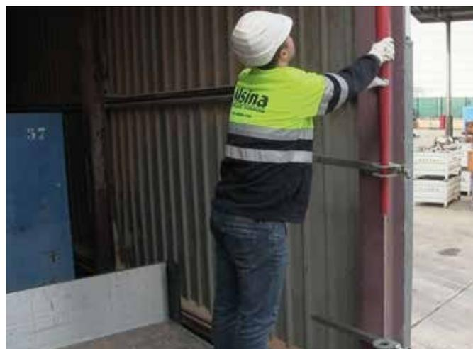
Mediante la utilización de elementos auxiliares se procederá a instalar el Alsipercha, incertándola a través de los agujeros principales de las dos pinzas hasta introducirse en el orificio central del elemento VASO que actuará de apoyo del extremo inferior del Alsipercha. El usuario ya estará en disposición de conectarse al dispositivo retráctil conectado al Alsipercha, y comenzar a desempeñar sus labores con total protección.
