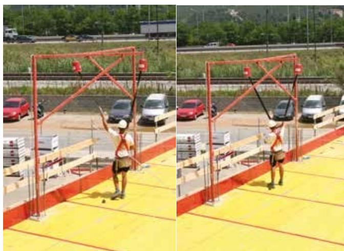
Una vez el operario está conectado al Alsipercha, se podrá comenzar con el proceso de entablado. Permite rotar 360° proporcionando un área segura de trabajo de 6,5 m de diámetro (125 m<sup>2</sup>). Mediante la utilización del accesorio bichero, podremos acercarnos al siguiente Alsipercha y proceder al cambio de sistema, garantizando así la seguridad del usuario en todo momento.
