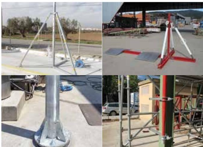
Una vez determinada y acondicionada la zona donde se tenga intención de instalar el sistema, se instalarán los accesorios de familia Alsipercha que se desee combinar con el RAIL.
