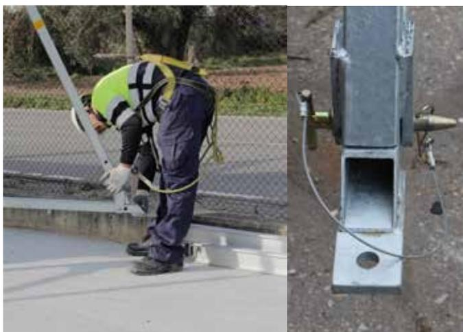
Mediante la utilización de equipos auxiliares para facilitar su manipulación, se abrirán y conectarán cada una de las patas del TRÍPODE mediante el pin de conexión incorporado.
