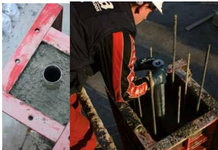
Para facilitar el trabajo con el sistema y optimizar su uso en obra, insertaremos los tubos de alojamiento en aquellos pilares que se sugiere planificar la ubicación de los sistemas en la planta a vayan hormigonando. Utilizaremos el nivelador para asegurar la encofrar. La planificación debe tener en cuenta los 6,5 m de radioverticalidad del tubo de alojamiento de acción máximo que proporciona el sistema.
