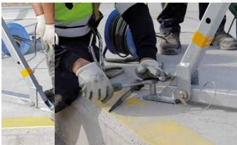
Una vez realizadas las perforaciones donde se colocarán las patas del TRÍPODE, se justarán los elementos de anclaje para asegurar la firmeza de su instalación.
