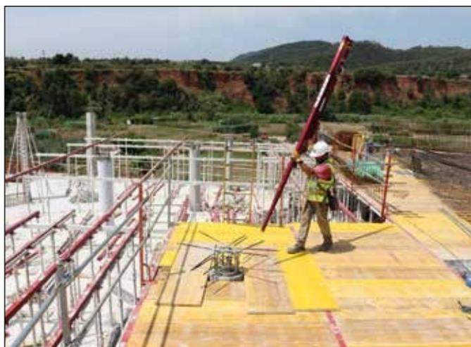
Una vez instalado el Alupercha dentro del tubo de alojamiento y se haya conectado el usuario, ya se podría comenzar con el proceso de entablado. Permite rotar 360° proporcionando un área segura de trabajo de 6,0 m de diámetro.
