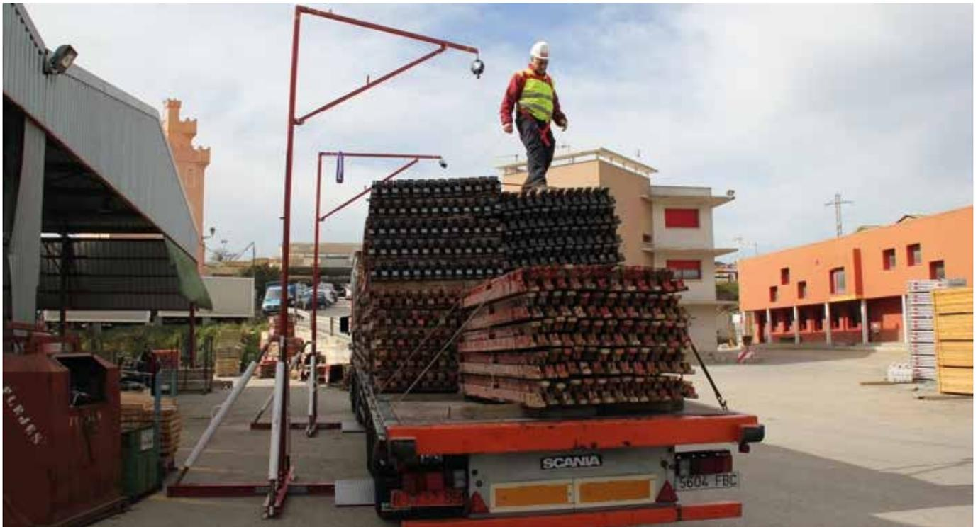
El sistema de contrapeso MF, dirigido a la aplicación durante las fases de carga y descarga de camiones, no requiere de ningún anclaje para su instalación.
