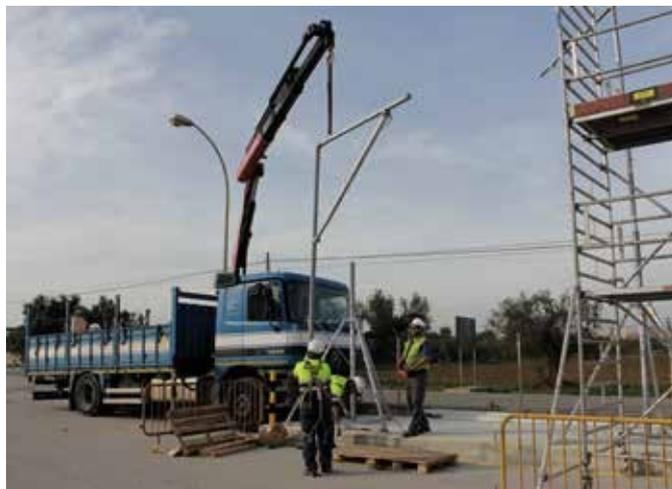
Mediante la utilización de equipos auxiliares, se insertarán todas las Alsiperchas en los accesorios instalados en el PASO 1.
