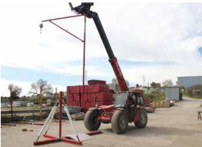
Mediante la utilización de elementos auxiliares, se procederá a insertar el Alsipercha, a través del orificio central del tubo principal del sistema, hasta que llegue a su tope final.
