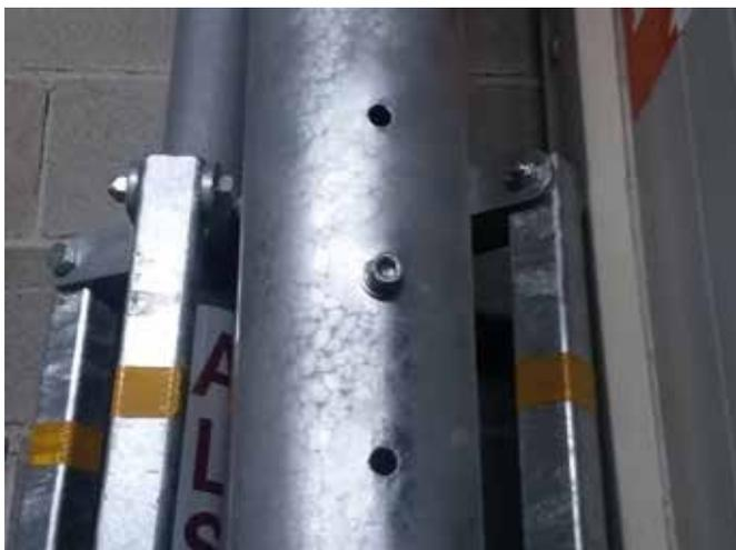
Seguidamente, se determinará en cuál de las posiciones del POSTE deberá hacer tope el Alsipercha, con el fin de corregir los posibles desviaciones en el nivel de la superficie donde se fuera a instalar.
