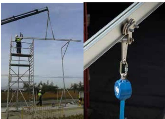
Mediante la utilización de equipos auxiliares, se instalarán los conectores RAIL elegidos (fijo/abatible) y los tramos de RAIL, junto con el carro de avance y el retráctil.
