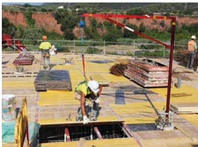
Mediante la utilización del accesorio bichero o manualmente, podremos acercarnos al siguiente Alupercha y proceder al cambio de sistema, garantizando así la seguridad del usuario en todo momento.
