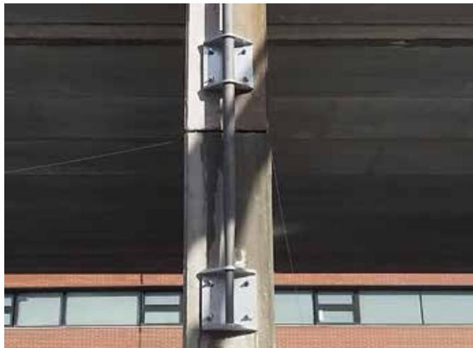
Determinar la altura final a la que se desee disponer el punto de anclaje del Alsipercha, para posteriormente proceder a realizar los agujeros donde serán colocados los anclajes de instalación. Una vez colocado el CONECTOR A MURO superior y el inferior, se fijarán los elementos de anclaje hasta el punto de sujeción máximo que garantice su adecuada instalación.
