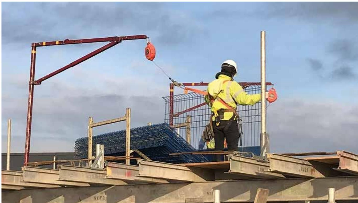
Sistema de protección individual que protege a los usuarios de las caídas en altura, especialmente útil en perímetros y para trabajos relacionados durante el entablado de encofrado horizontal.
