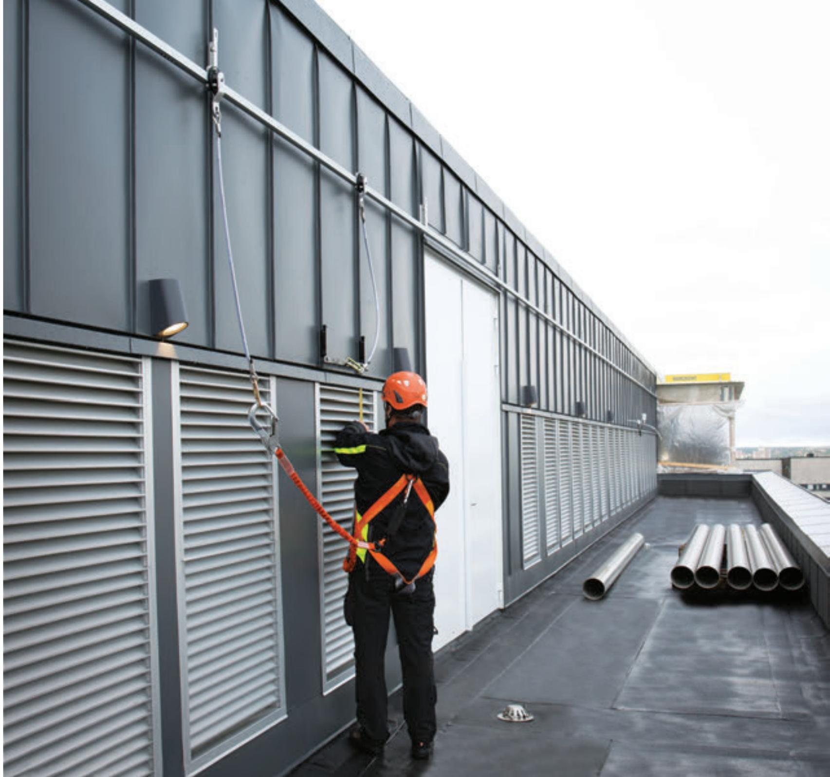
→ SecuRail es un sistema anticaídas rígido que puede instalarse a suelo, pared o techo. Su forma rectangular se integra en la estética de los edificios. La unión en cruz absorbe las posibles dilataciones por cambios de temperatura.
