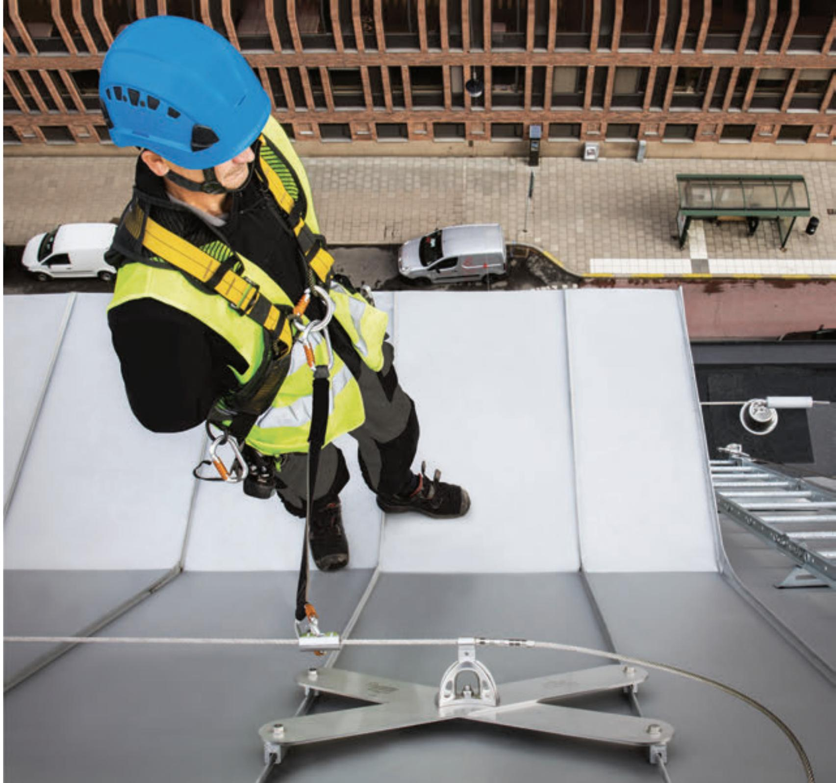
→ El soporte de fijación para junta alzada se sujeta de la costura sin perforar la cubierta.
