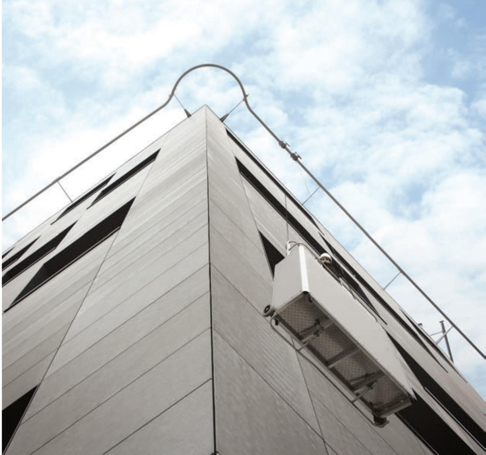
→ El SafeAccess para trabajos suspendidos es un sistema eficiente para el mantenimiento y limpieza de fachadas.
