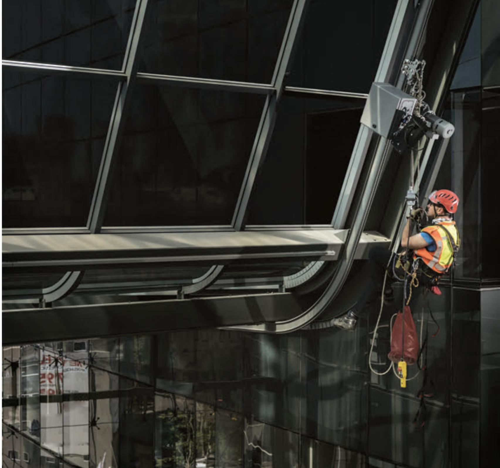
→ El SafeAccess para ascenso se instala en fachadas inclinadas o en atrios para el mantenimiento y limpieza del edificio. Una cadena de acero inoxidable de alta resistencia pasa a través del canal inferior del monorraíl.
