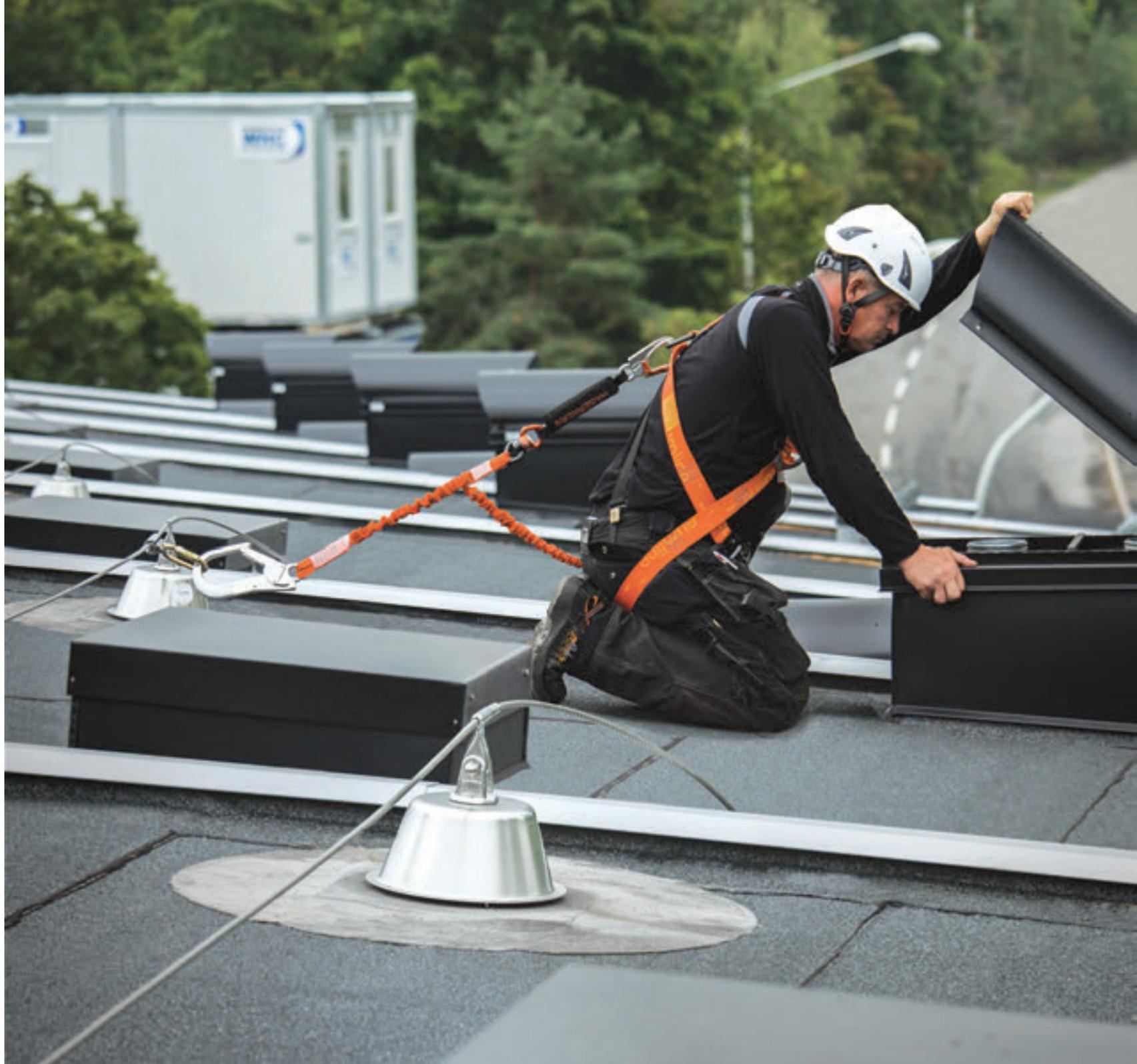
→ El Multipost y SpotAnchor están diseñados para cubiertas hot deck.
