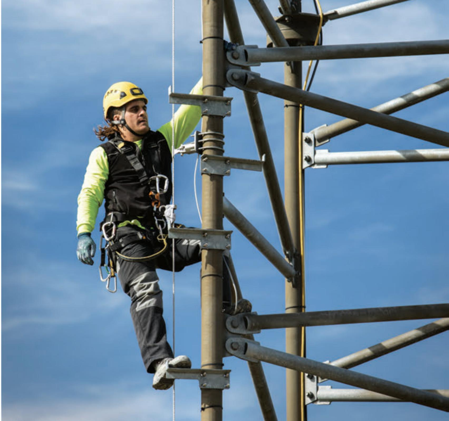
→ SecuRope Vertical garantiza un acceso seguro gracias a que el carro anticaídas tiene una conexión muy cercana al usuario que acorta el desplazamiento en caso de caída. El carro anticaídas ZIP, equipado con absorbedor de energía, reduce la fuerza transmitida al usuario.
