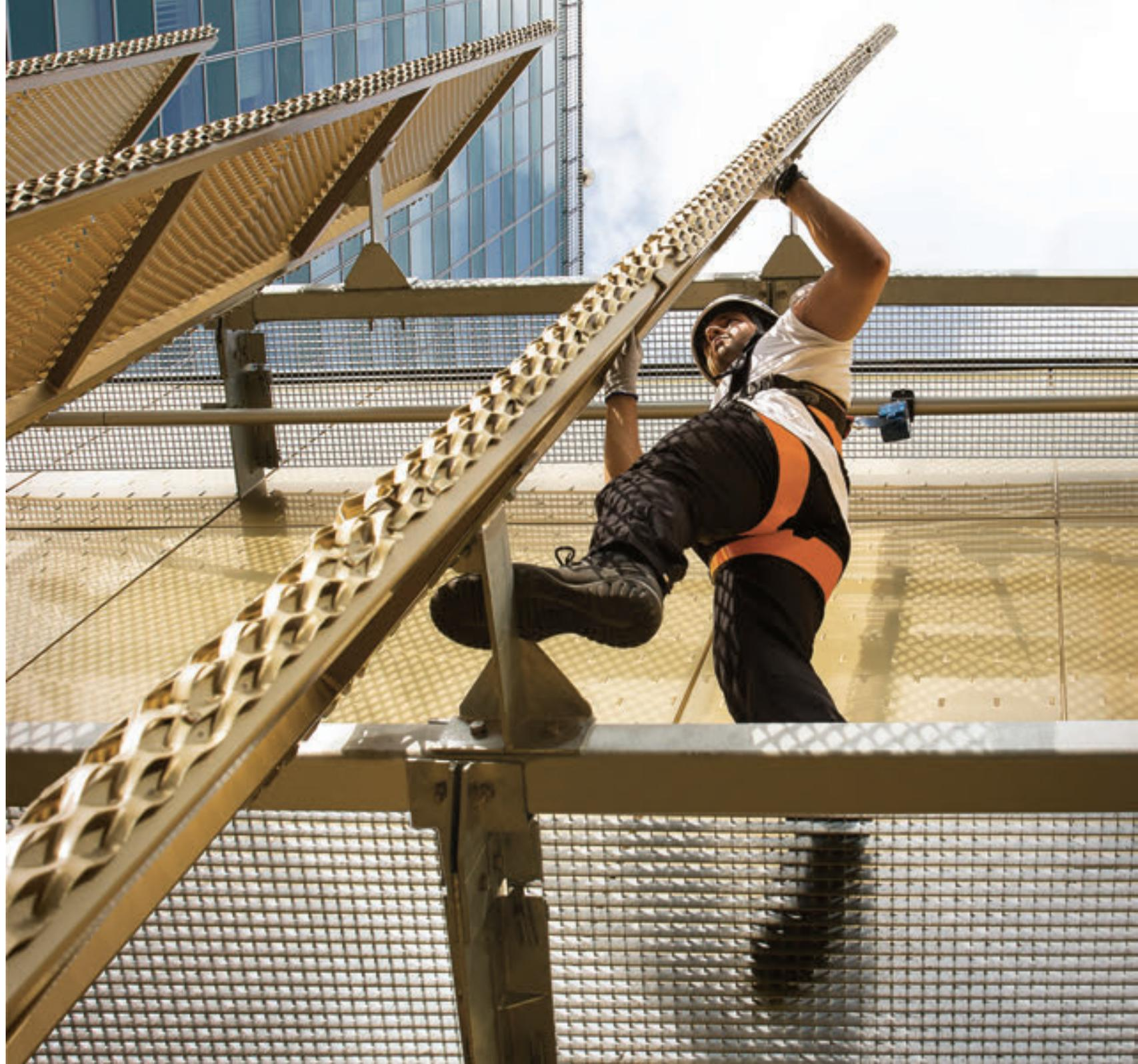
→ Anticaídas retráctiles certificados para la configuración a suelo, pared y techo. El sistema de detección de sobrevelocidad bloquea la caída a una distancia mínima de desplazamiento. El mecanismo de absorción de energía integrado garantiza que la fuerza máxima transmitida al usuario sea de 6 kN.
