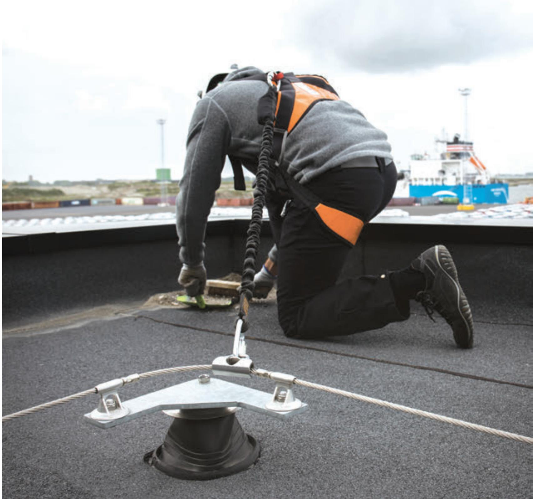
→ El poste indeformable Fallprotec es una opción segura para estructuras rígidas como hormigón o vigas de acero.
