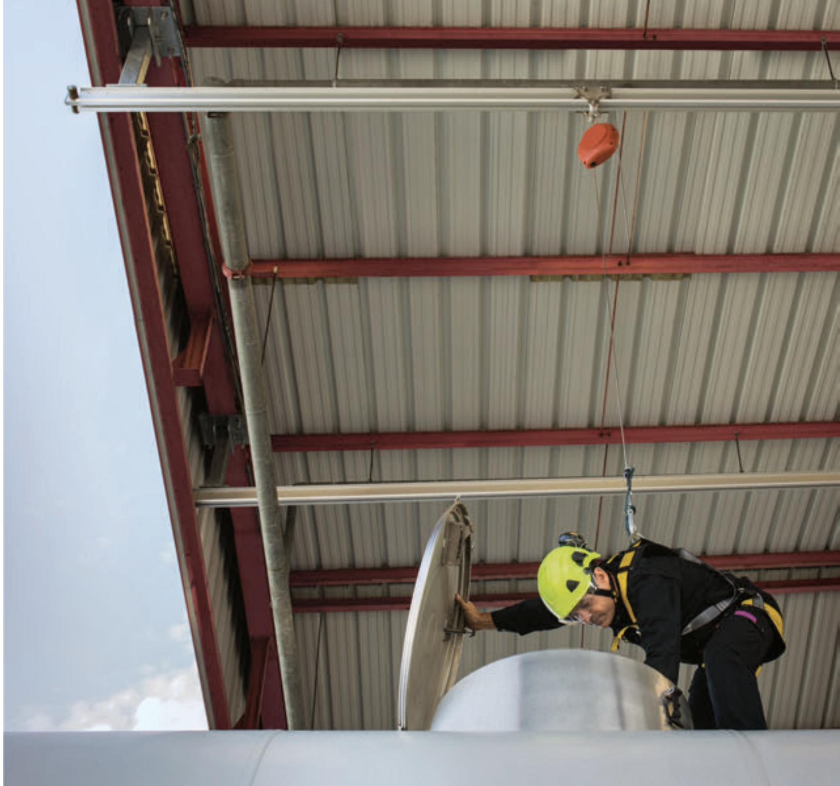
→ El SafeAccess es un sistema anticaídas no deformable ideal para aplicaciones industriales. Instalado en la configuración a techo, es el sistema más adecuado cuando la distancia de caída libre es reducida.
