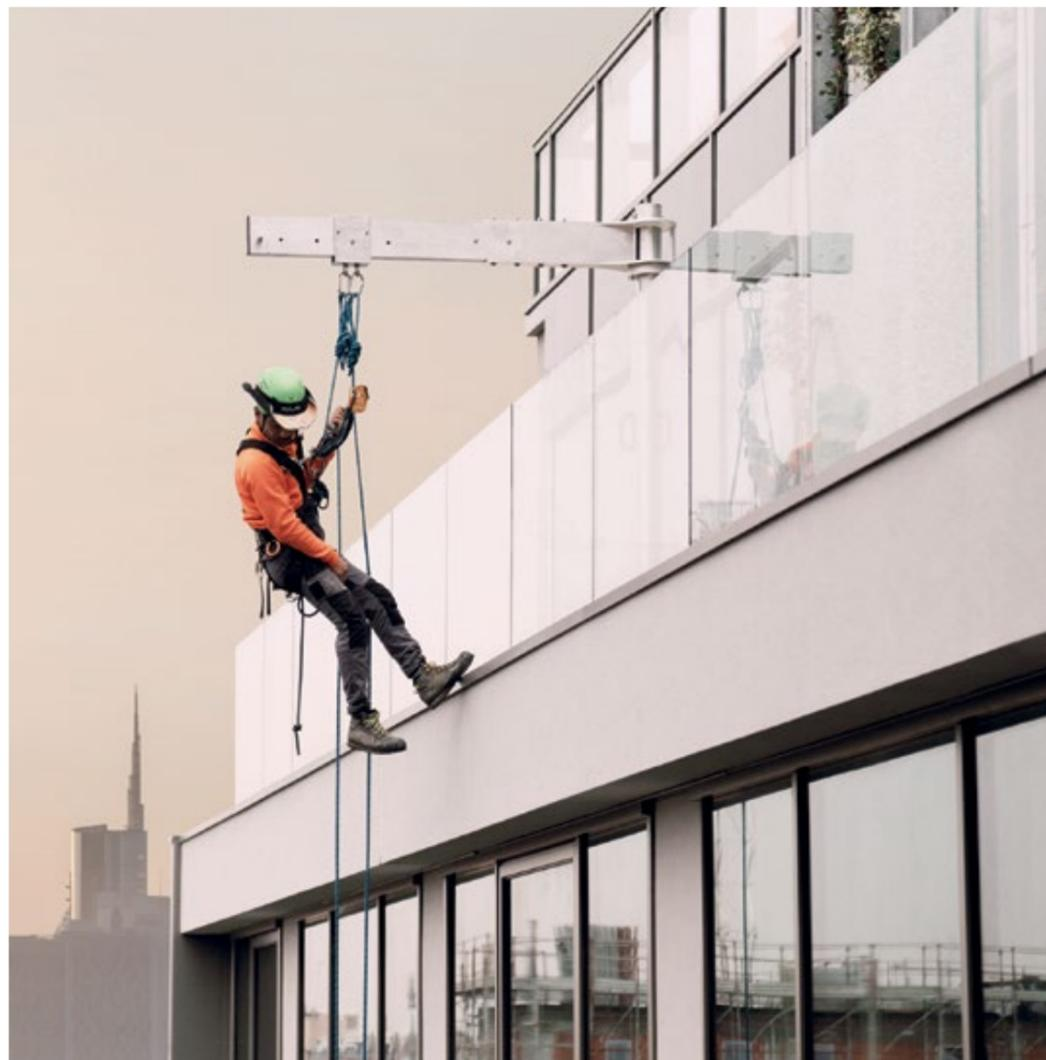
La pluma pescante extraíble está diseñada para suspender a un operario que realiza trabajos de mantenimiento o limpieza en una fachada. El pescante puede ser utilizado por un especialista en acceso por cuerda, por una silla RopeClimber o por una monocesta Ropeclimber. El pescante se instala al techo en bases fijas a lo largo del perímetro del edificio. Al final del trabajo, el pescante se desmonta y se almacena.
